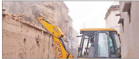
नांगल चौधरी। शहर में जर्जर भवन गिराती जेसीबी। फोटो: हरिभूमि
